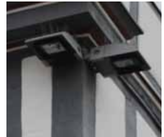
Unscheinbar aber effektiv: LED-Strahler werden an den Fassaden angebracht.
