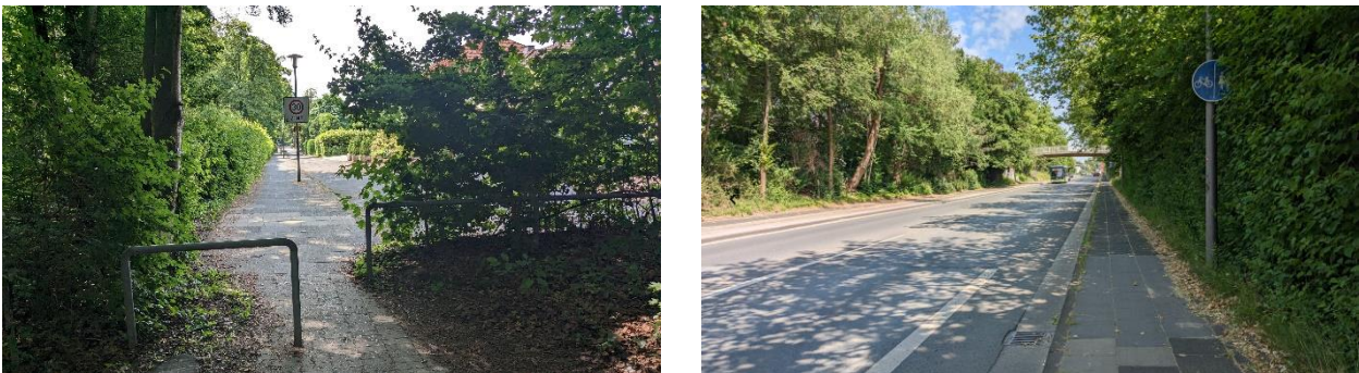
Abbildung 34: fehlende Überleitung zwischen baulichem Radweg und Führung auf der Fahrbahn (Lange Straße, der bauliche Radweg ist in beide Richtungen benutzungspflichtig; links) und fehlende Überleitung ohne Rückenschutz an der Alemannenstraße (rechts)
