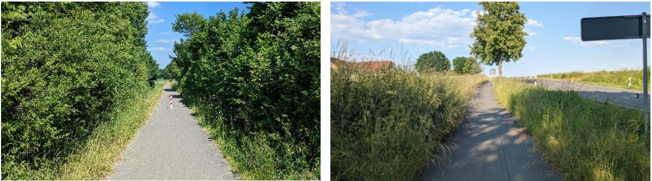
Abbildung 35: Bewuchs auf gemeinsamen Geh- und Radweg ragt stark ins Sichtfeld, sodass entgegenkommende Radfahrer nicht gesehen werden können
