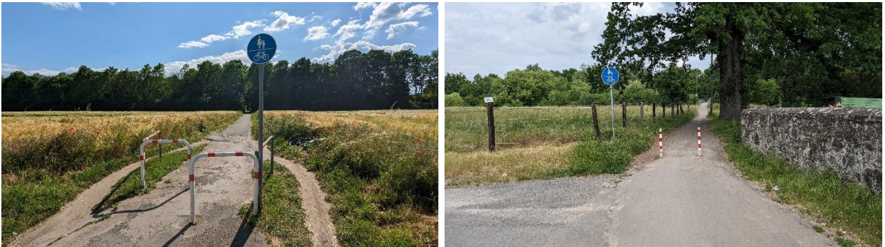
Abbildung 33: Gefahrenpunkte auf der Strecke: Umlaufsperrungen (links) und Poller (rechts), wobei der Durchgang eine unzureichende Breite aufweist
