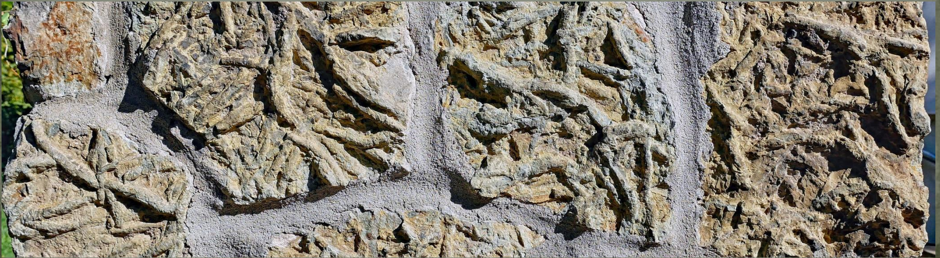
Etwa 1 m breite Bruchsteinmauer aus „Rankensteinen“ als Teil der Einfassung des Grundstücks Spinozastraße 8 in Hannover-Kleefeld, aufgen. 01.09.2022.
