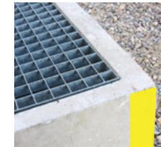
**2** Durch eine **Erhöhung** der Lichtschachtoberkanten kann Wassereintritt verhindert werden. Diese Maßnahme ist auch noch nachträglich umsetzbar.
