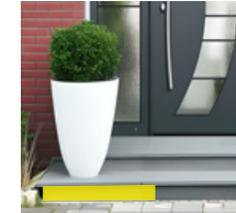
**1** Das Wasser kann über Türen eindringen. Dies kann z. B. durch erhöhte Hauseingänge mit **Stufen** verhindert werden.
