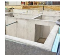
**5** Bei Neubauten wird durch den Einsatz von wasserundurchlässigem Beton (Weiße Wanne) der Kellerbereich u. a. gegen drückendes Grundwasser geschützt.
